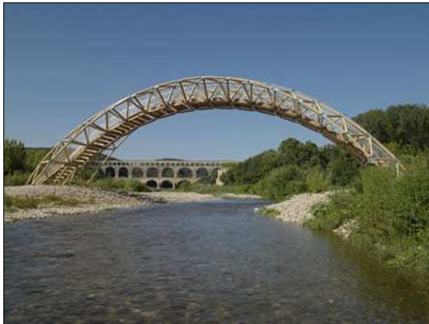
Shigeru Ban - Cầu xây bằng giấy, Remoulin, France, 2007
